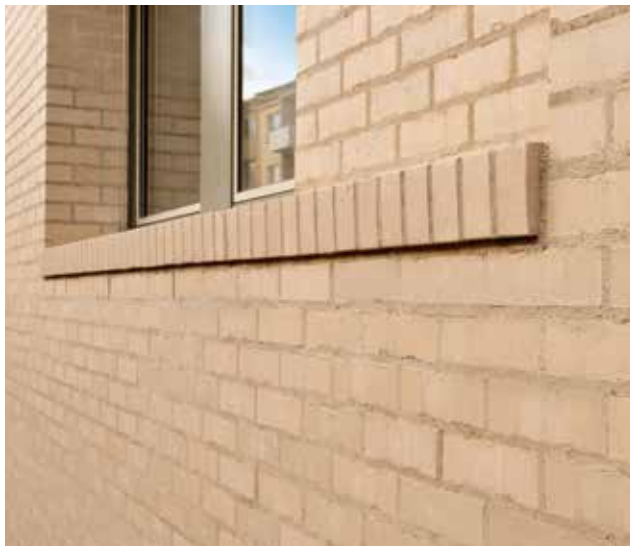
Bündig abgezogene, nicht zusätzlich verdichtete Mörtelfugen.
