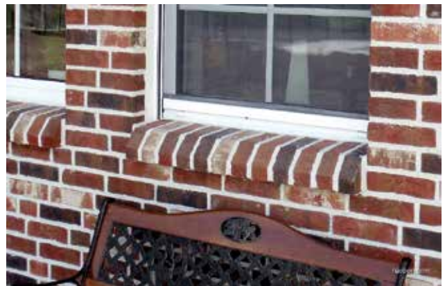
Beispiel für eine Fensterbank-Rollschicht mit Wärmedämmung
