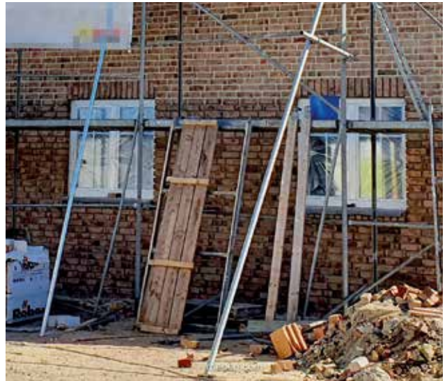
Der Fugenmörtel im oberen Bereich verändert den Fassadeneindruck enorm: MOORBRAND lehm-bunt.
