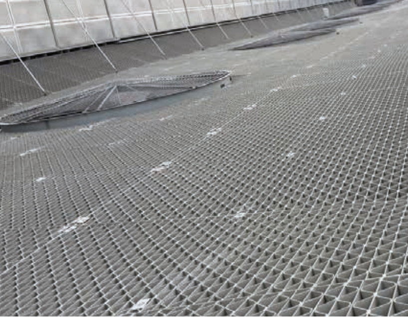
ZORLU CENTER / TRİCO İZGARA KAPLAMA ZORLU CENTER / TRICO GRID CLADDING
