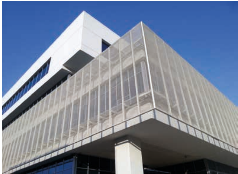
BURSA SOĞANLI KÜLTÜR MERKEZİ / MESH CEPHE BURSA SOĞANLI CULTURAL CENTRE / MESH FACADE
