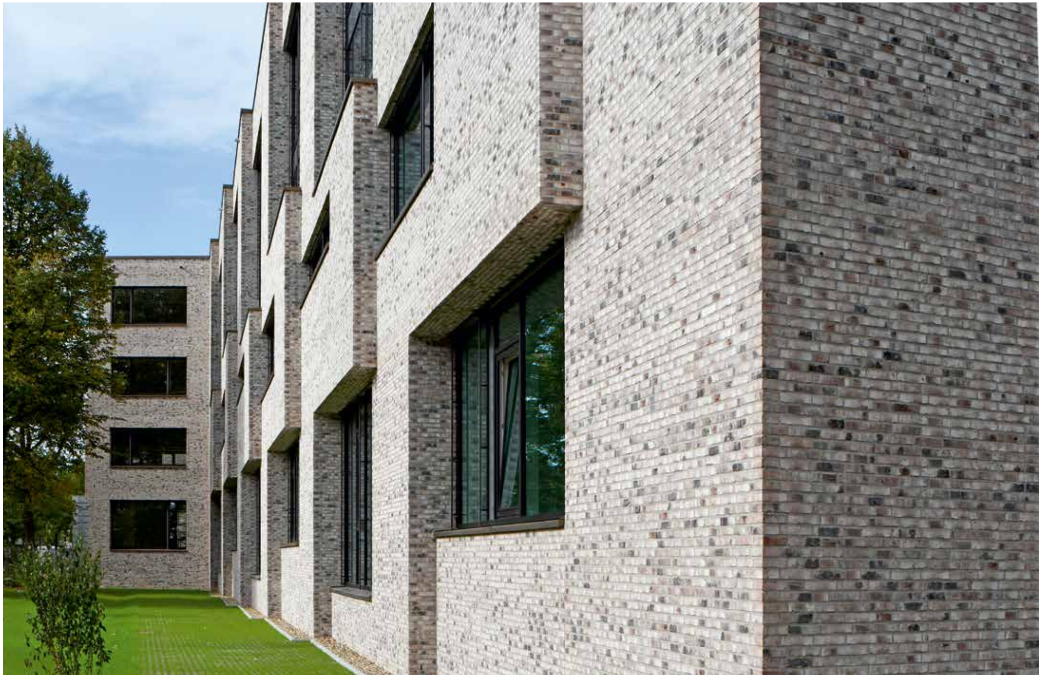
Schulzentrum in Hamburg | APB. Architekten BDA, Hamburg | WIESMOOR kohle-weiß , DF
