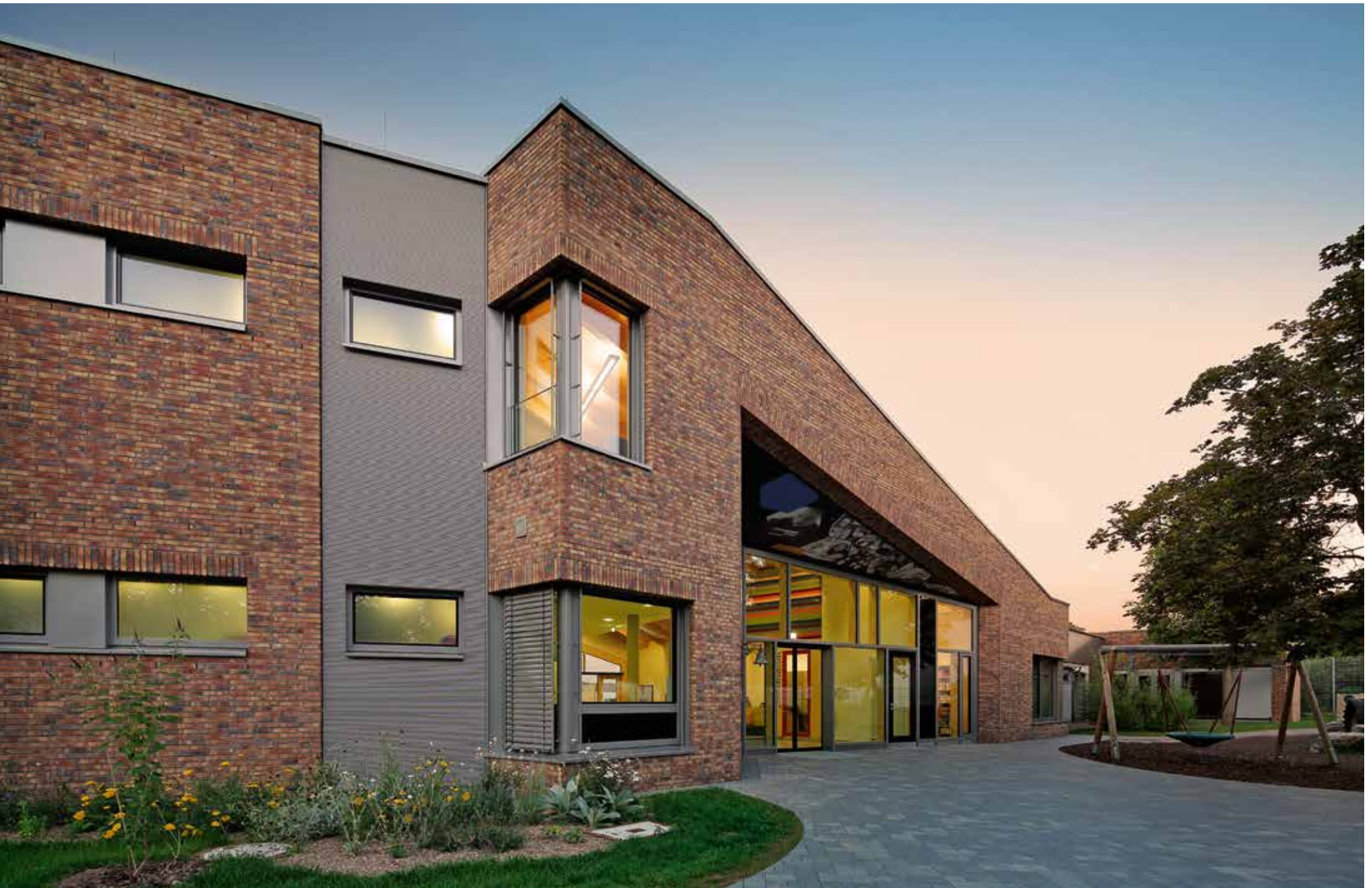
Private Inklusionsschule in Fulda | Staubach + Partner Architekten / Ingenieure Generalplaner, Fulda | WIESMOOR erd-bunt , DF
