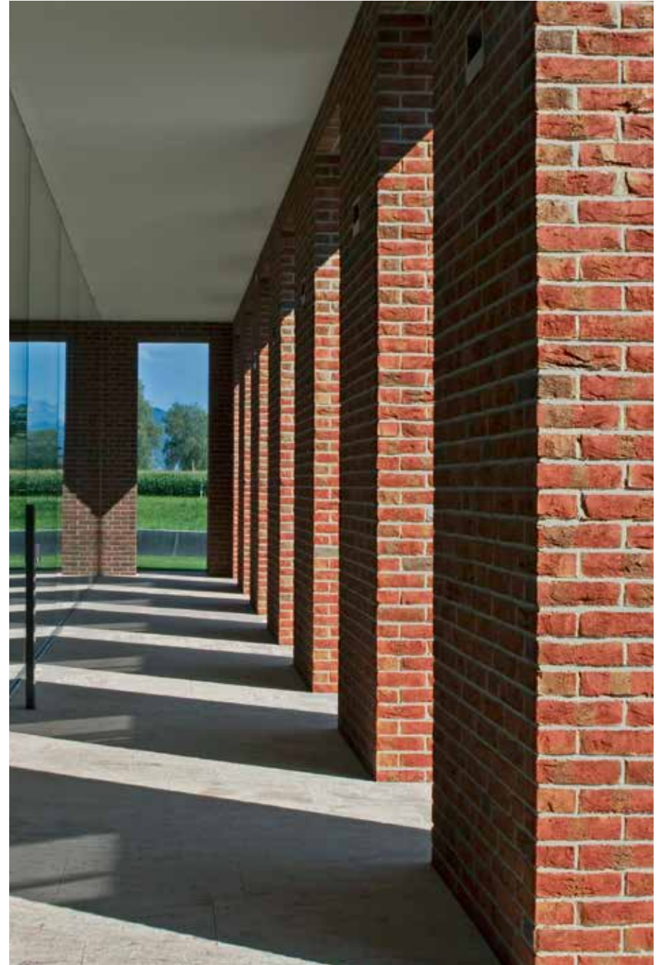
Produktionsgebäude in Balgach (CH) | Baumschlager Eberle Architekten, Lochau (A) | WASSERSTRICH hellrot-bunt , NF
