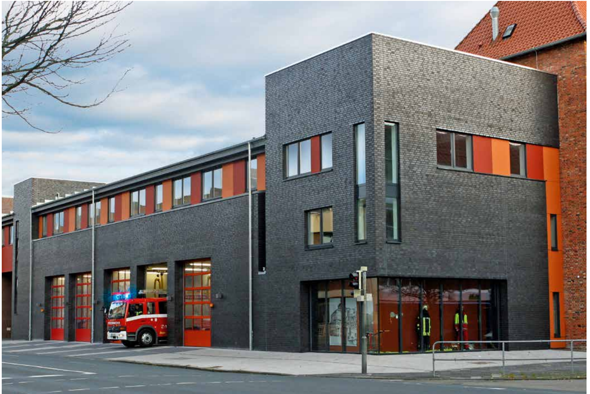
Feuerwache in Wilhelmshaven | Griesemann & Griesemann Architekten, Wilhelmshaven | CAMBRIDGE NF
