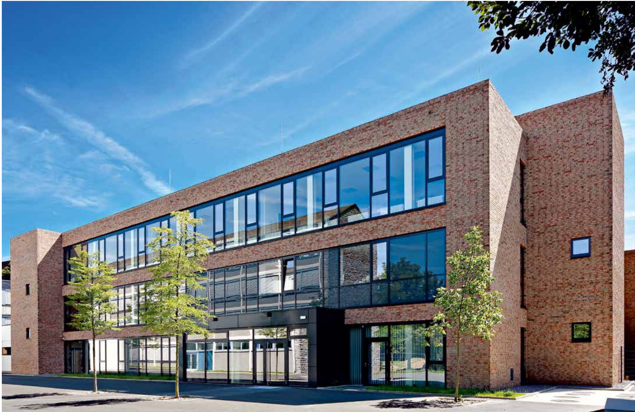
Mensa der Abtei Königsmünster, Meschede | soan architekten boländer / hülsmann GbR, Bochum | MOORBRAND lehm-bunt, NF
