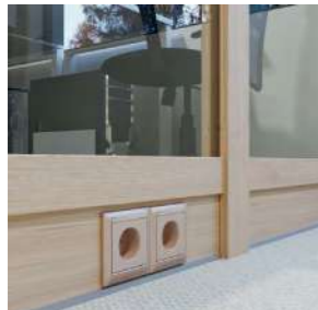
Плинтус в шпоне позволяет нивелировать неровность пола.
