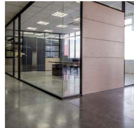
G Переход одинарного стекла на панели Junction of a single-glass wall with a panel
