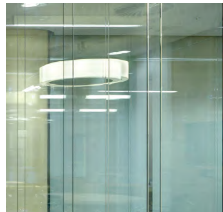
F Стыковка стекла Glass junction
