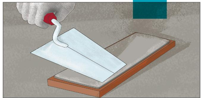
4. После этого состав **ROCKmortar** наносят на тыльную сторону плиток. Далее при приклеивании плитку следует плотно вдавливать в раствор и слегка смещать в сторону.
