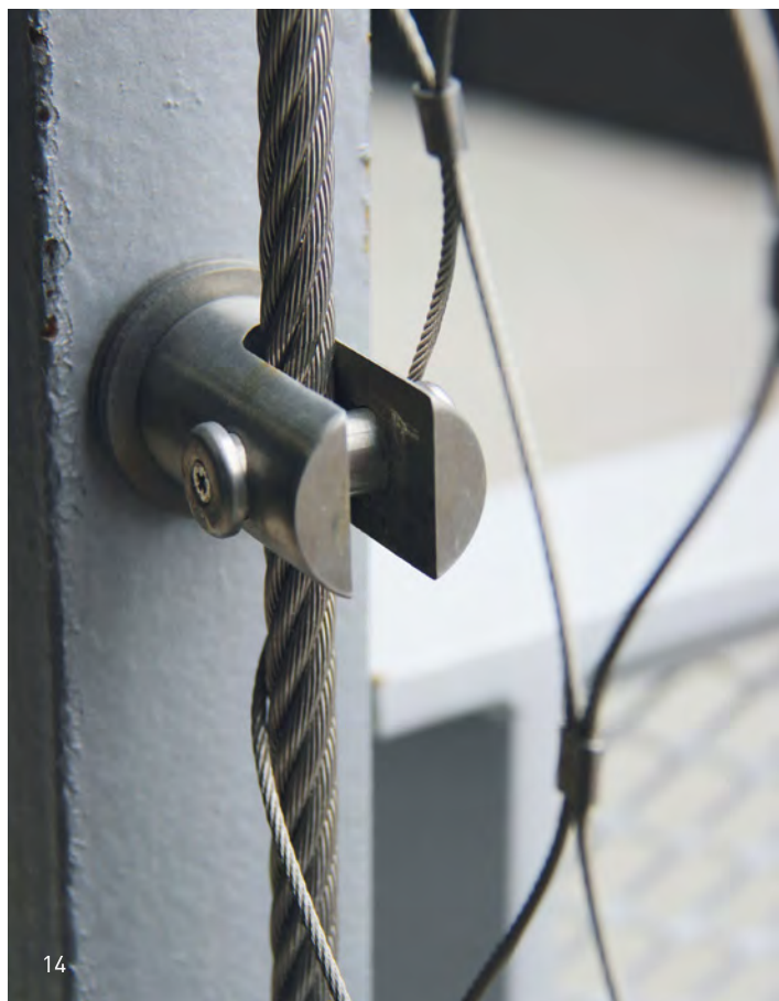
13 Randseilführung mit Seilführung zylindrisch an Betonkonstruktion Border cable rope holder on concrete structure
