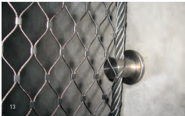
8 Randseilführung und Gabelanschluss Border cable guide, and fork head attachment
