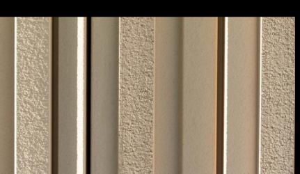
Auch die Technik der Profilierung in Senken und Höhen, in gleichen oder unterschiedlichen Breiten signalisiert Individualität auf der Basis der matten Keramikoberfläche. Die Einwirkung auf der Oberfläche lässt sich darüber hinaus mit dem Einbringen bestimmter Oxide herstellen und dabei unregelmäßig Punkte "erblühen", die sich von der übtigen Fläche abheben.
